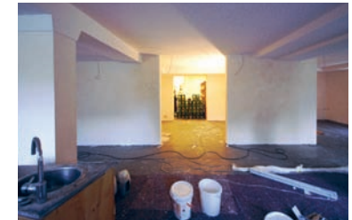
Das Neue wird sichtbar
