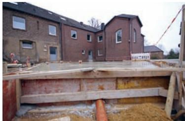
Das Fundament und die erste Mauer
