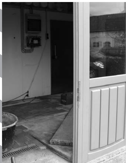
Verlegen der Fliesen
